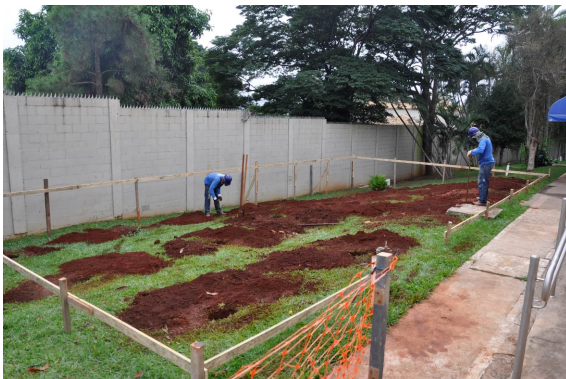
15/05/2017 – LOCAÇÃO E GABARITO, PERFURAÇÃO DE BROCAS
