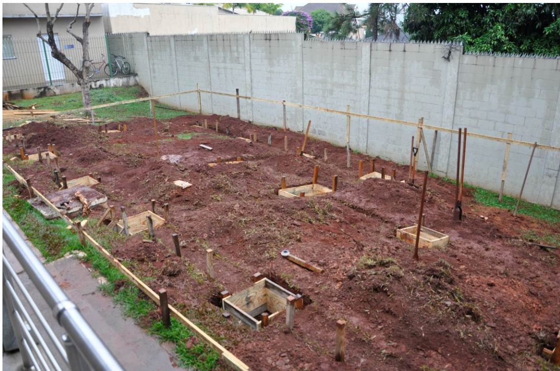
18/05/2017 – FÔRMAS DE FUNDAÇÃO
