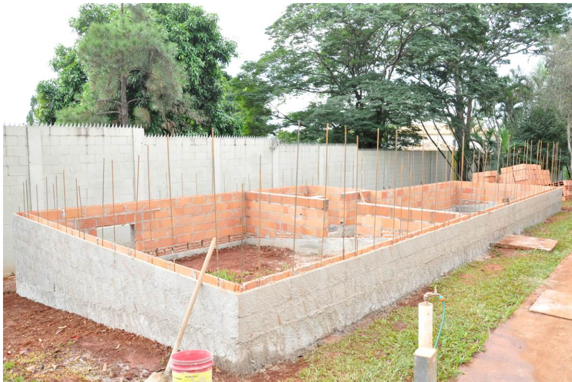
1º/06/2017 – TÉRMINO EMBASAMENTO E CHAPISCO EXTERNO
