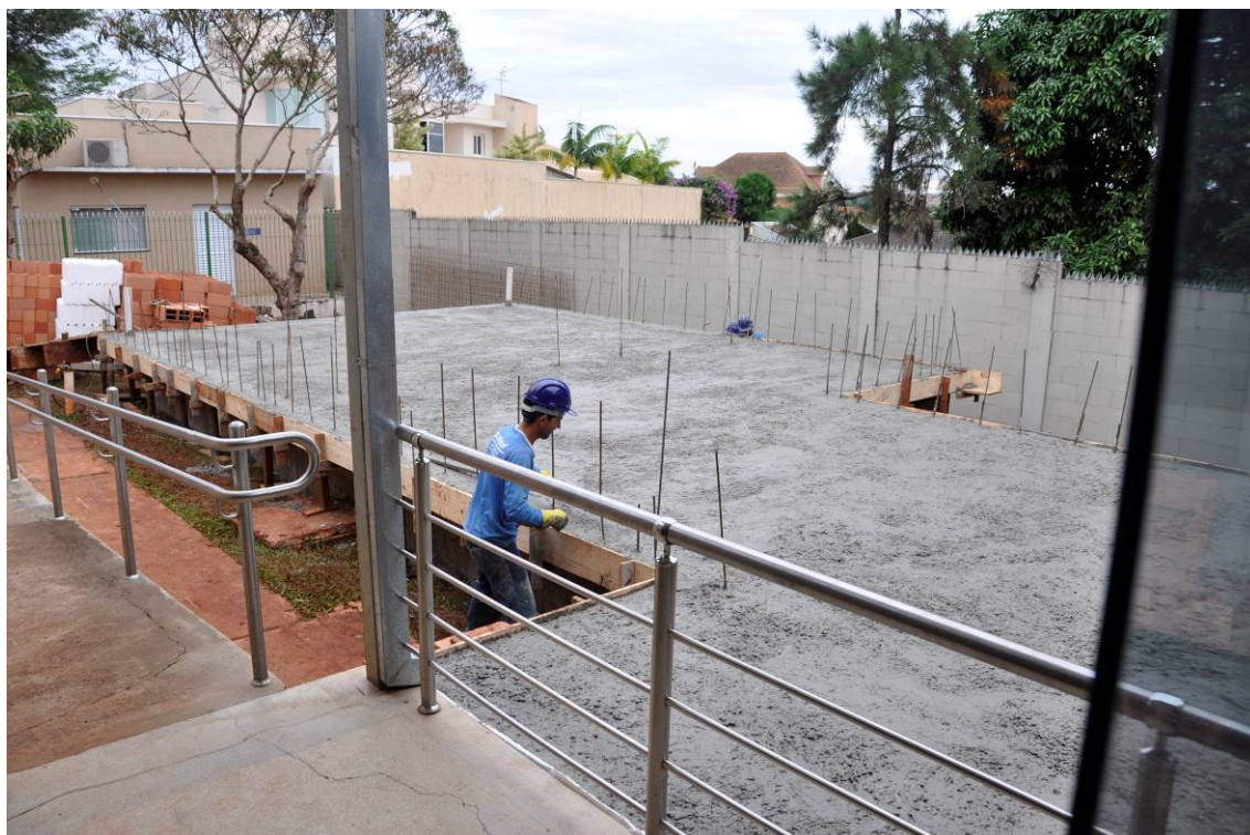
09/06/2017 – CONCRETAGEM DA LAJE DE PISO
