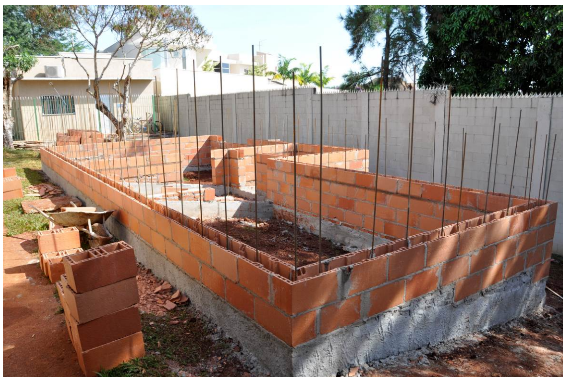
30/05/2017 – TÉRMINO DA ALVENARIA DE EMBASAMENTO
