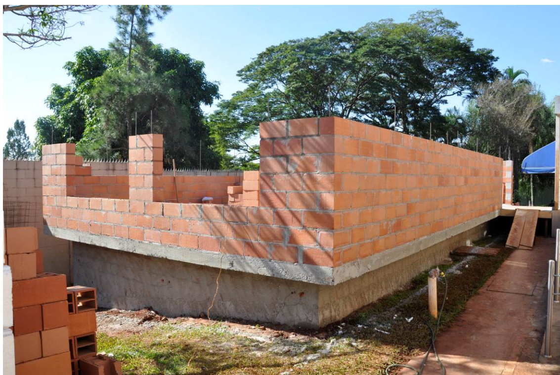
19/06/2017 – ALVENARIA ESTRUTUTRAL 8ª FIADA (CANALETA)
