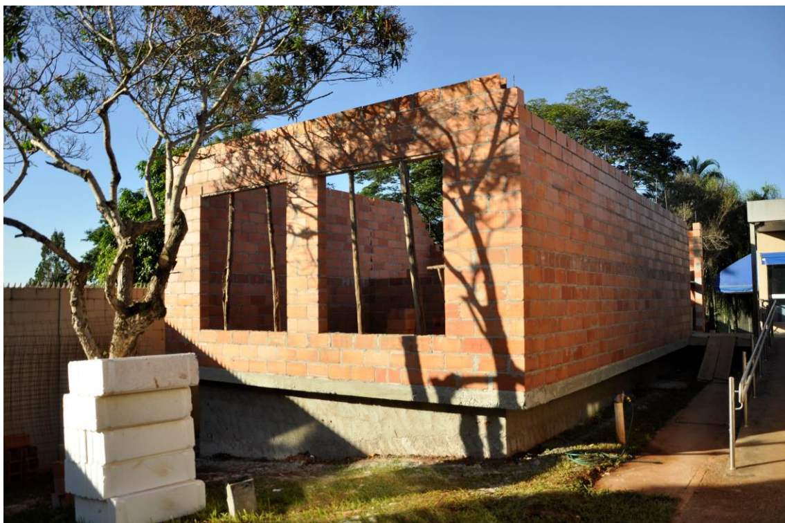
23/06/2017 – ALVENARIA ESTRUTURAL
