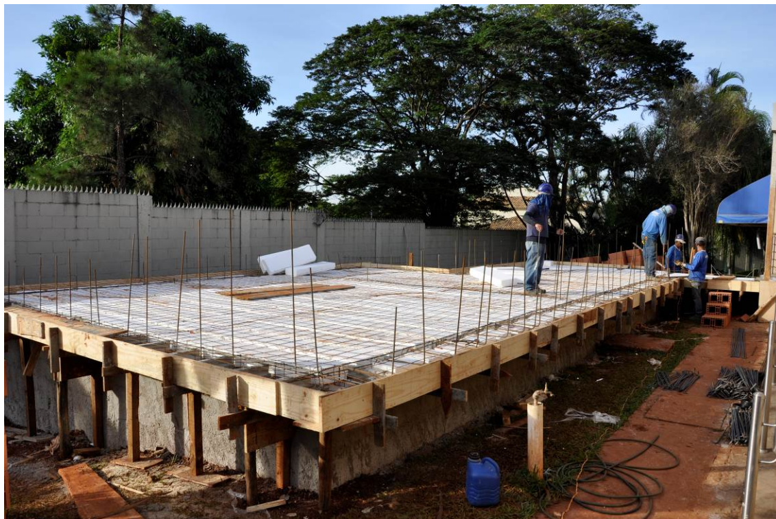
08/06/2017 – TÉRMINO DA MONTAGEM DA LAJE DE PISO
