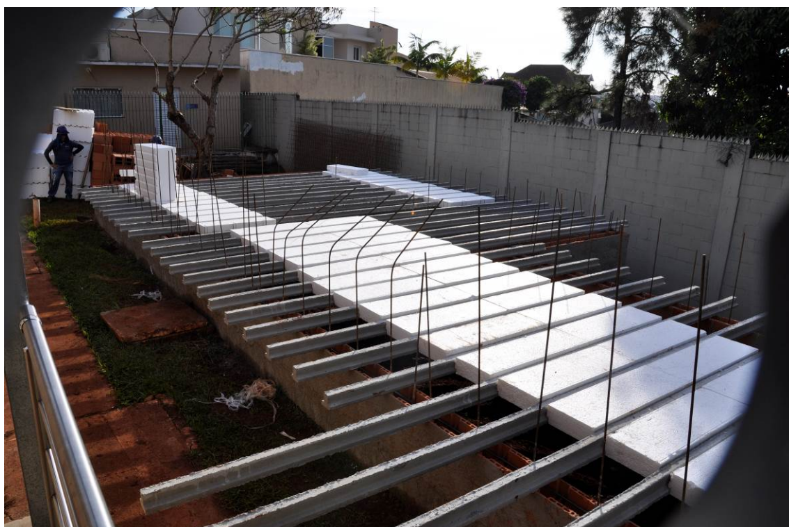
06/06/2017 – MONTAGEM DA LAJE DE PISO
