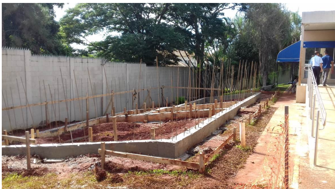
23/05/2017 – CONCRETAGEM DAS FUNDAÇÕES
