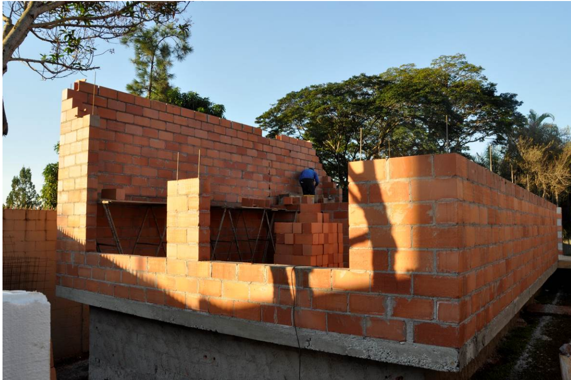
21/06/2017 – ALVENARIA ESTRUTURAL
