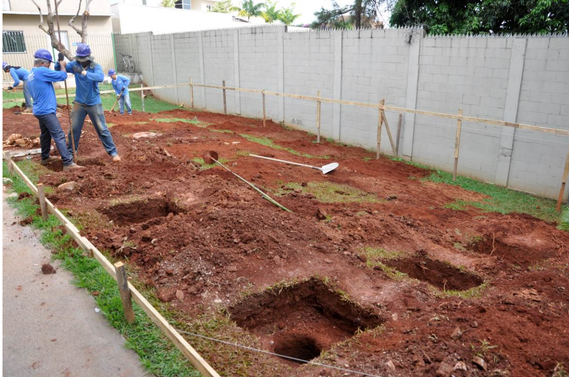
16/05/2017 – ESCAVAÇÃO BLOCOS DE FUNDAÇÃO
