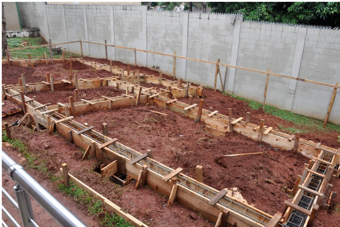
22/05/2017 – FÔRMAS E ARMADURA DE FUNDAÇÃO
