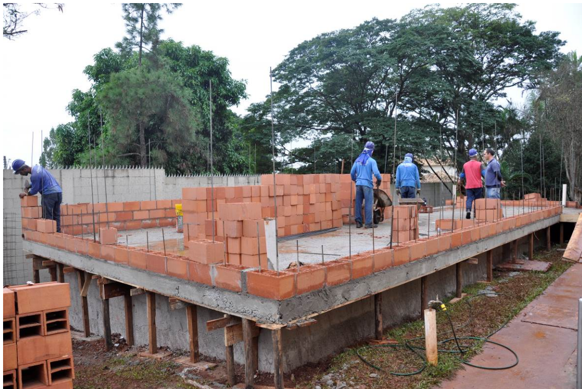
13/06/2017 – MARCAÇÃO PRIMEIRA FIADA E INÍCIO DA ALVENARIA
