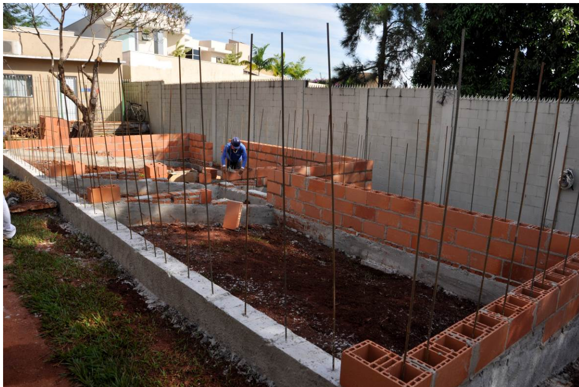
29/05/2017 – ALVENARIA DE EMBASAMENTO E NIVELAMENTO
