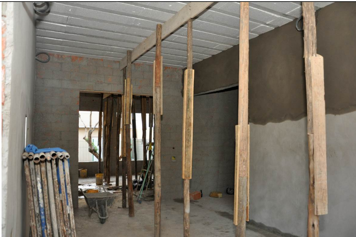
24/07/2017 – Reboco interno, parcialmente em altura de respaldo.
