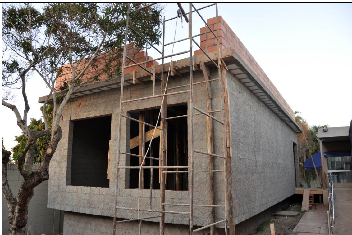
12/07/2017 – Alvenaria da platibanda. Remoção do escoramento do beiral.
