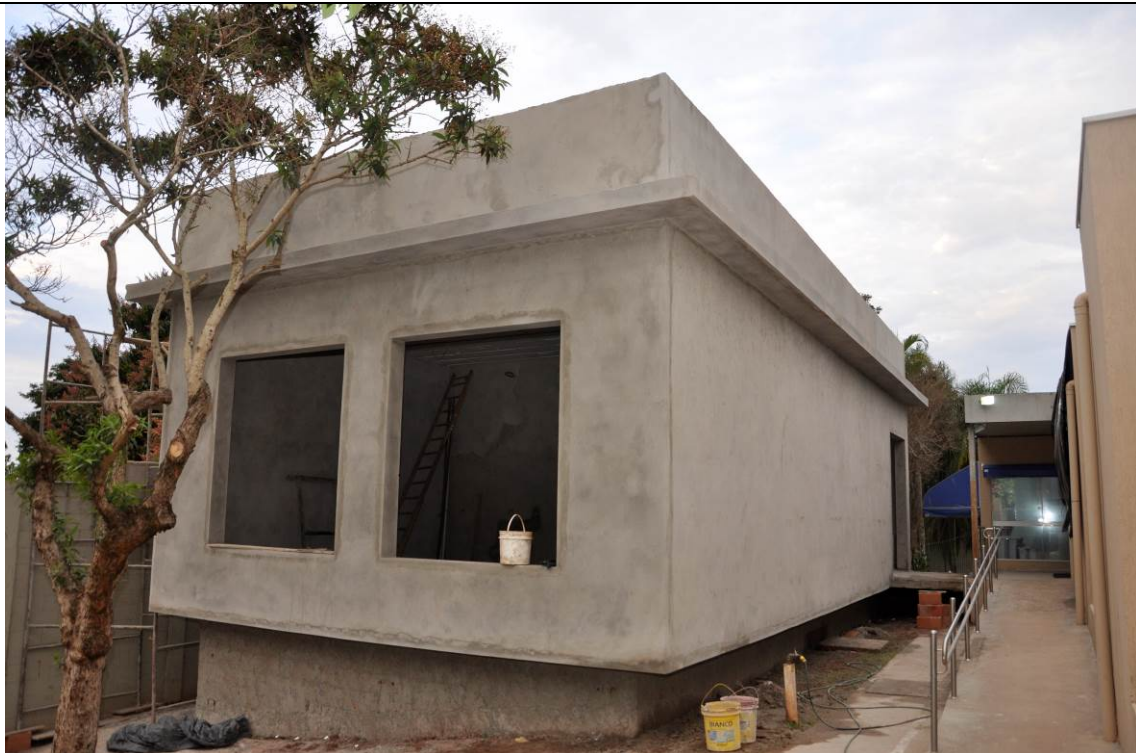
15/08/2017 – Término do reboco externo
