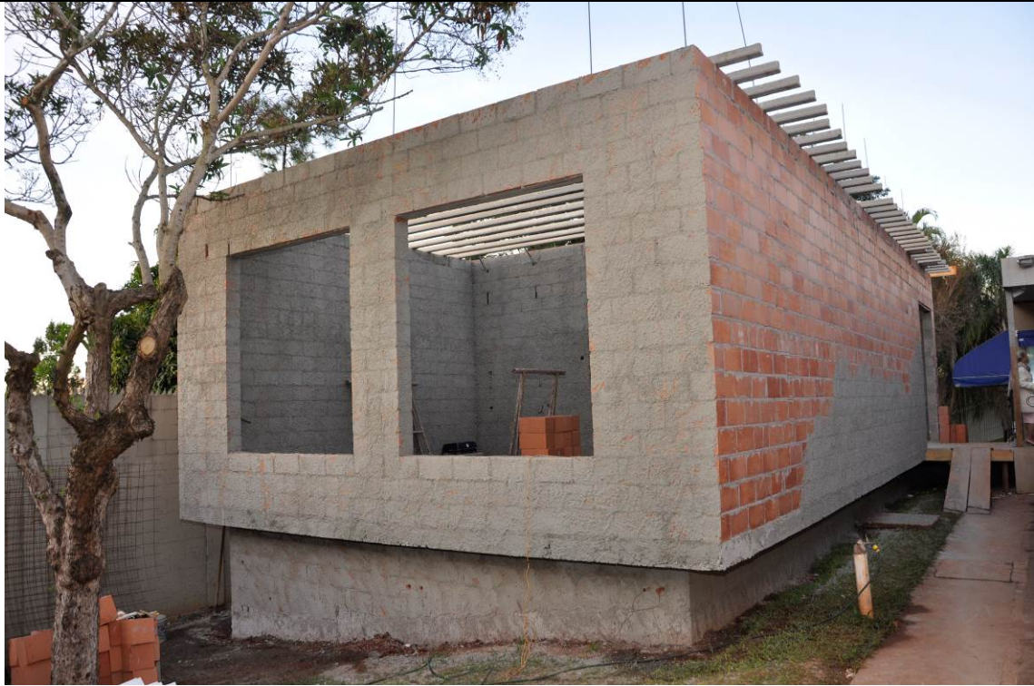
03/07/2017 – Chapisco externo e interno e término do posicionamento da laje pré-moldada
