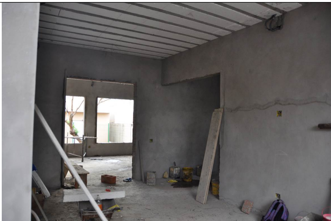
31/07/2017 – Reboco interno concluído. Início dos requadros das aberturas.
