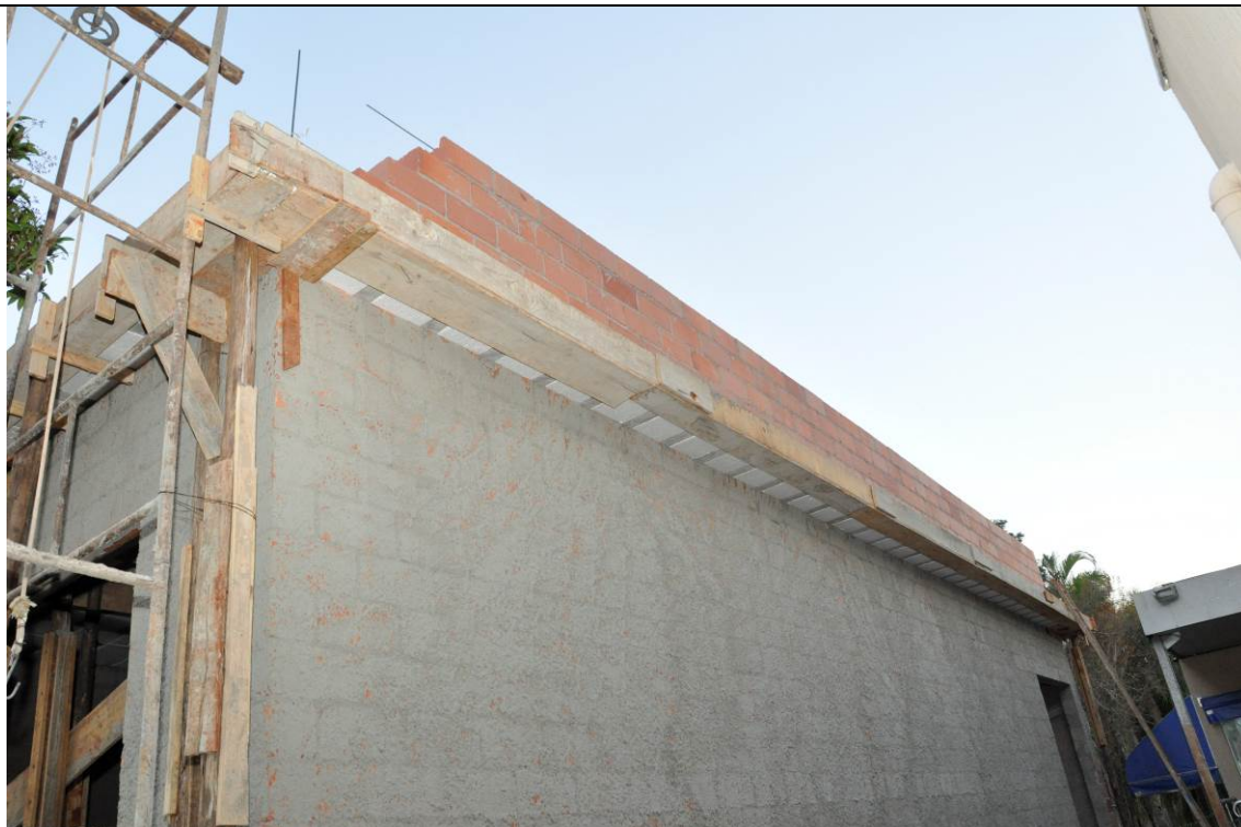
11/07/2017 – Alvenaria da platibanda
