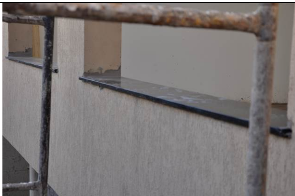
06/09/2017 – Pintura externa (grafiato) e emassamento interno (massa corrida)
