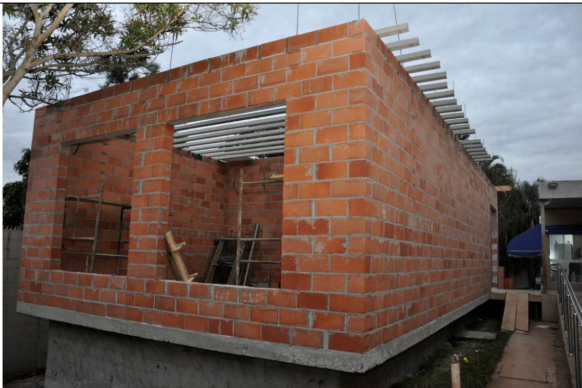
30/06/2017 – Montagem laje de forro
