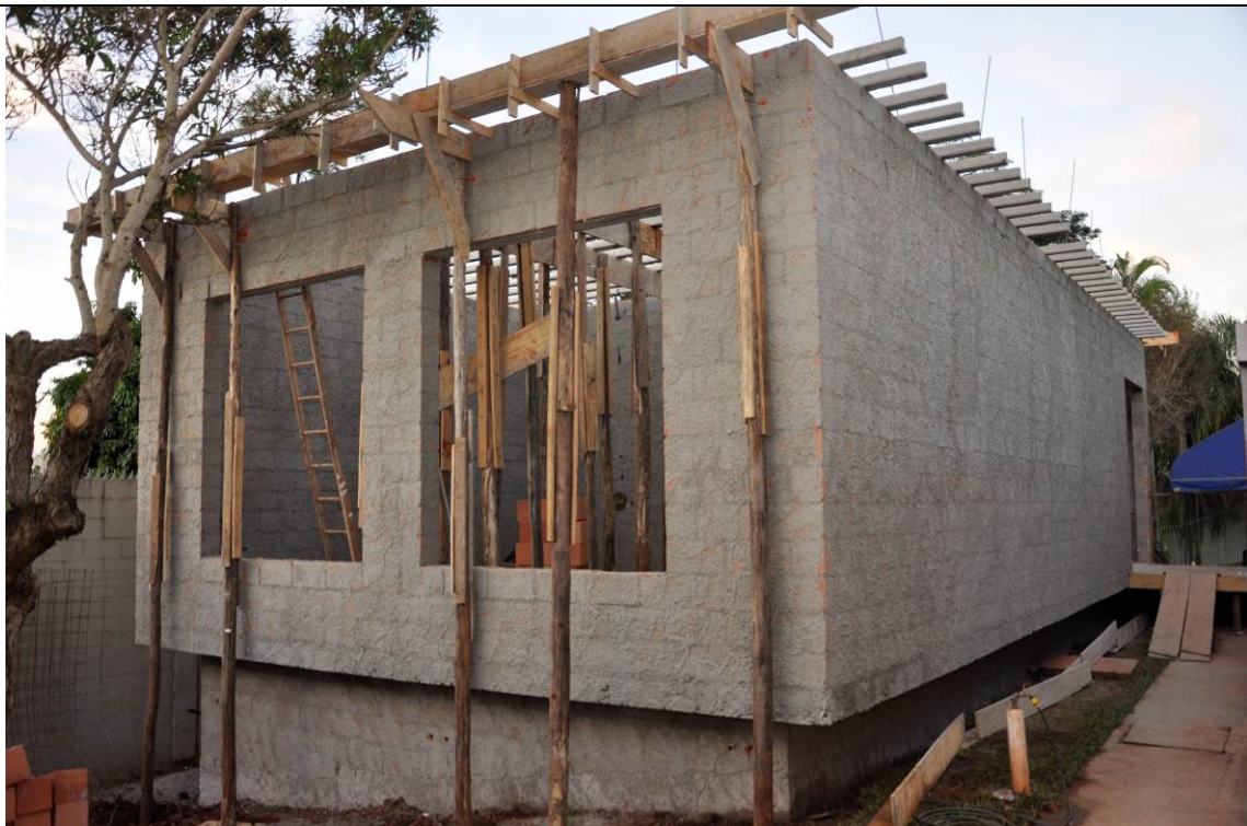
04/07/2017 – Escoramento laje e beiral, término do chapisco
