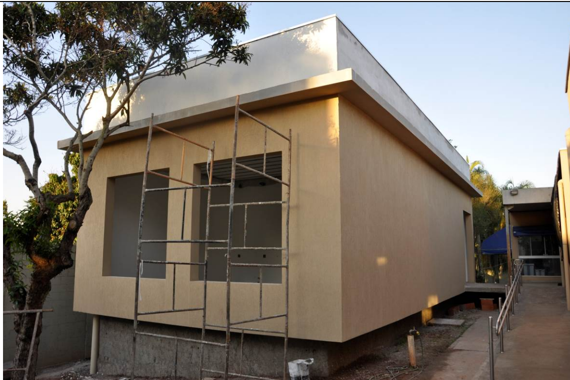
06/09/2017 – Pintura externa (grafiato) e emassamento interno (massa corrida)
