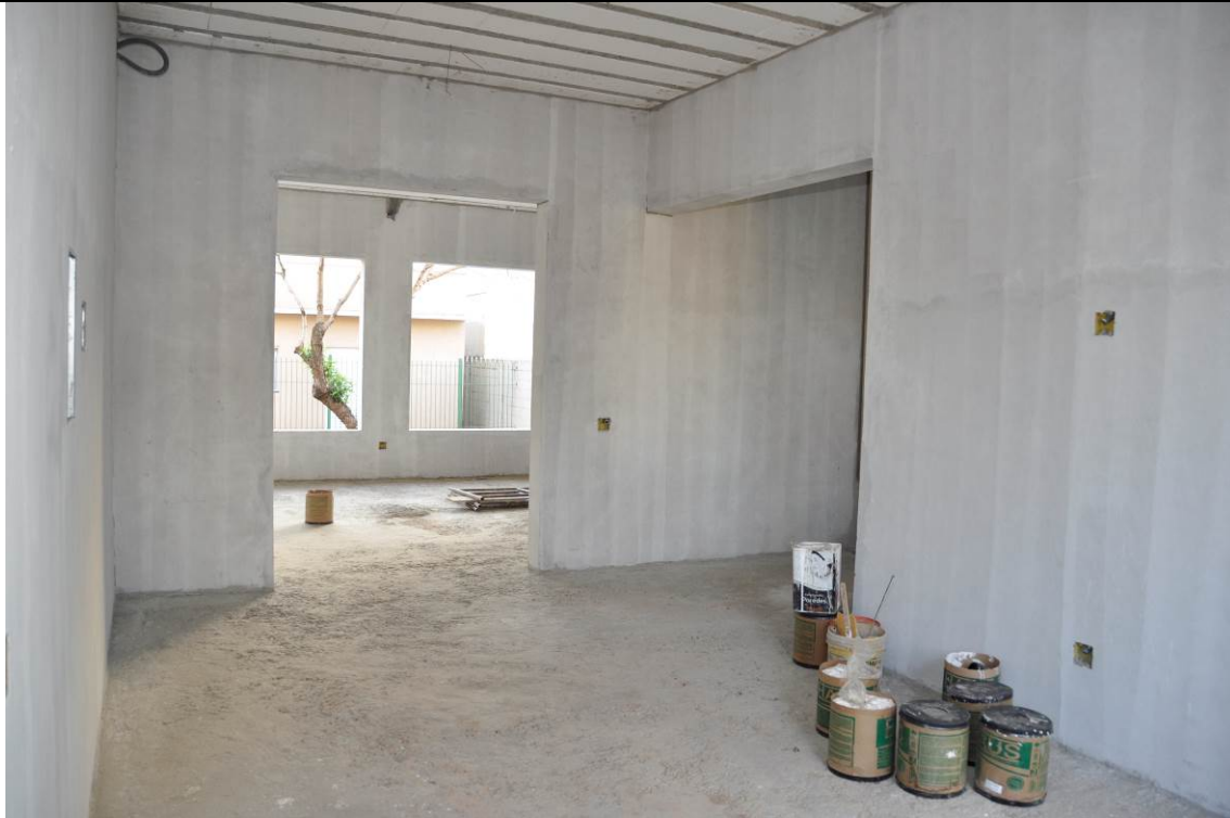
25/08/2017 – Aplicação de selador
