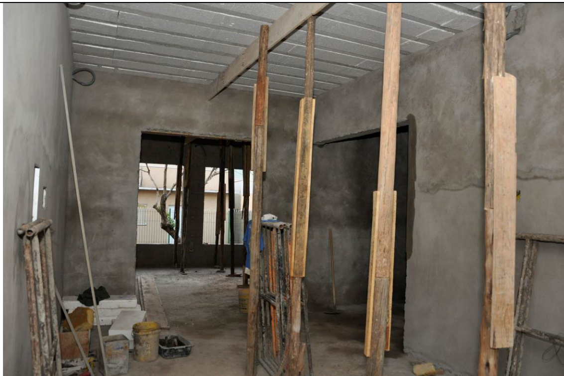
26/07/2017 – Reboco interno, parcialmente em altura de respaldo.
