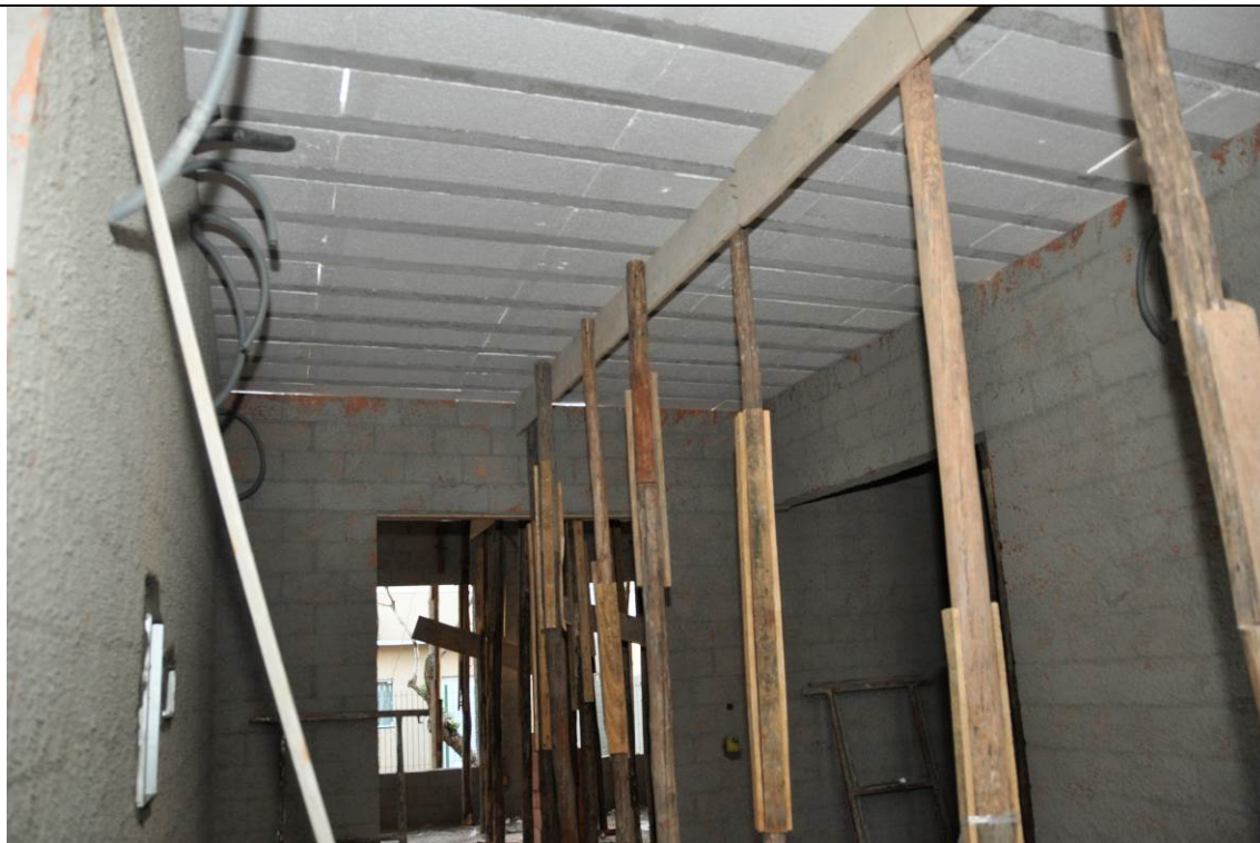
05/07/2017 – Montagem laje (lajotas de EPS), chumbamento de quadros e caixas
