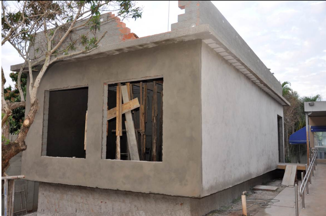
18/07/2017 – Emboço/reboco externo e interno. Término do assentamento de caixas e tubulações
