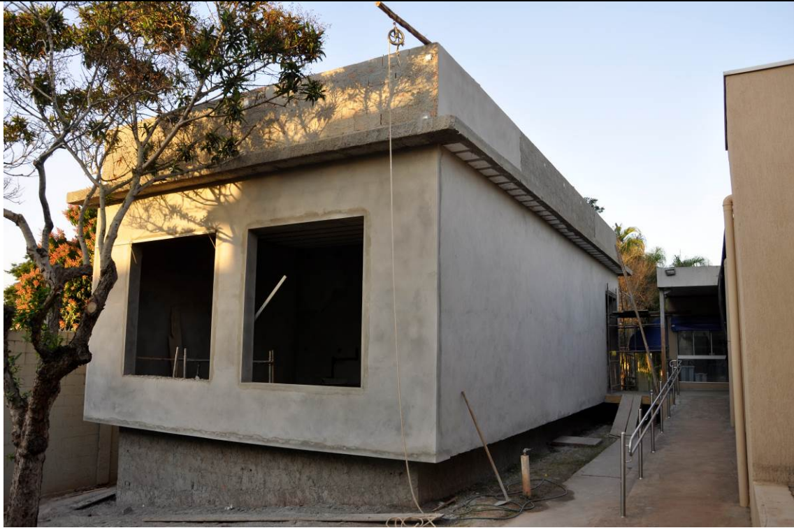
02/08/2017 – Reboco (requadros e platibanda)
