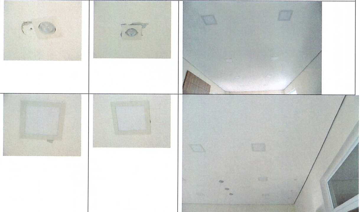
Reparo do revestimento do forro de gesso em alguns pontos de iluminação
