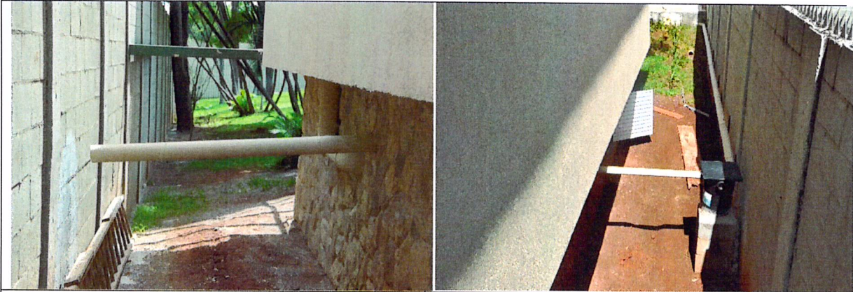
Arremate (revestimento/pintura) da face lateral da laje de piso no acesso ao refeitório. Instalação de guarda-corpo.
