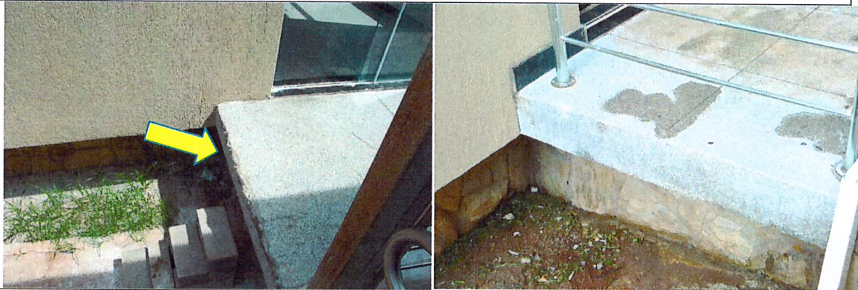
Instalação do deck de madeira (material disponível no canteiro de obras) e respectivo guarda-corpo
