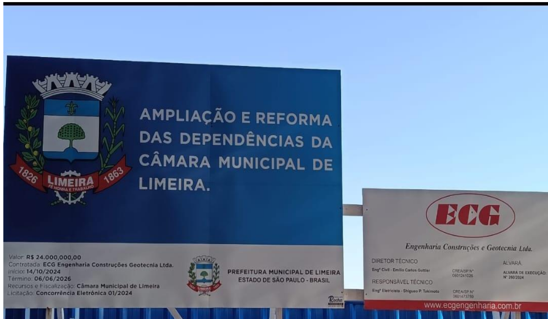
PLACA DE IDENTIFICAÇÃO DA OBRA
