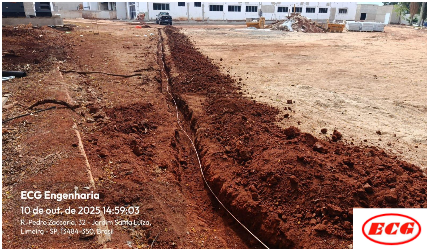
Malha de Aterramento do Poste do Estacionamento
