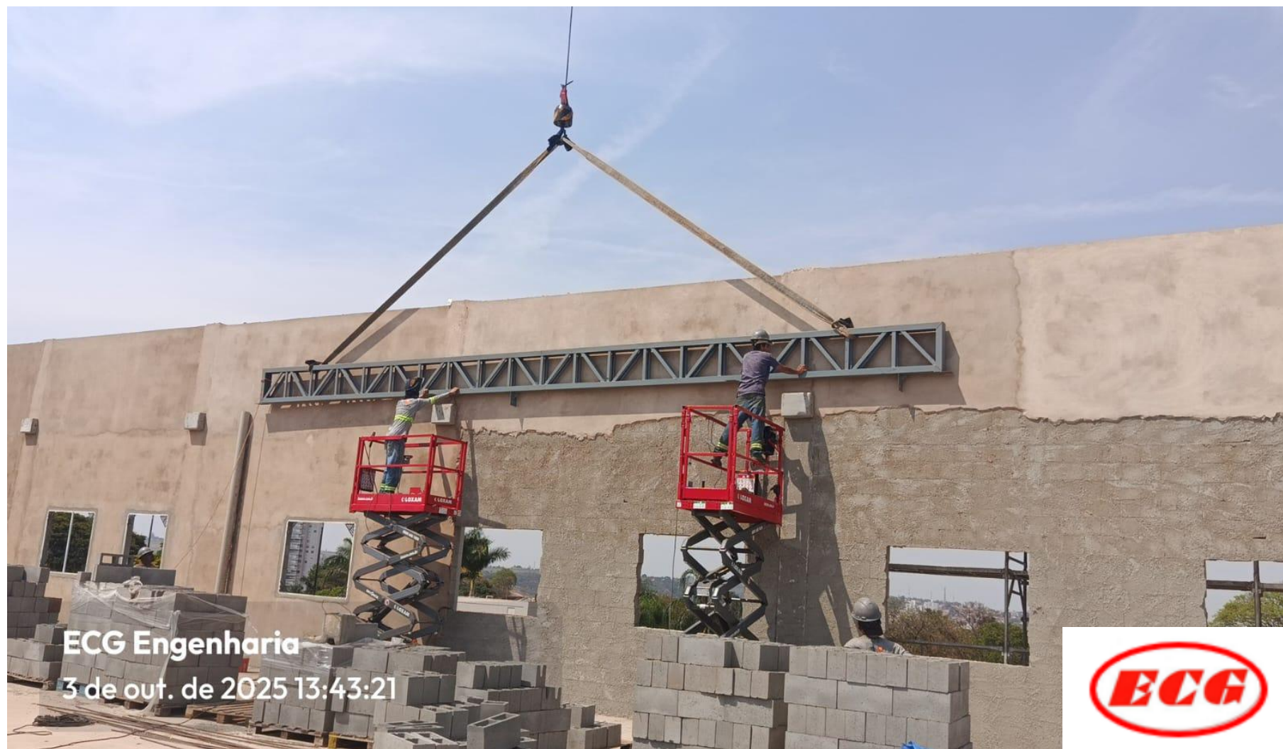
Montagem das Vigas de Bordo da Ampliação
