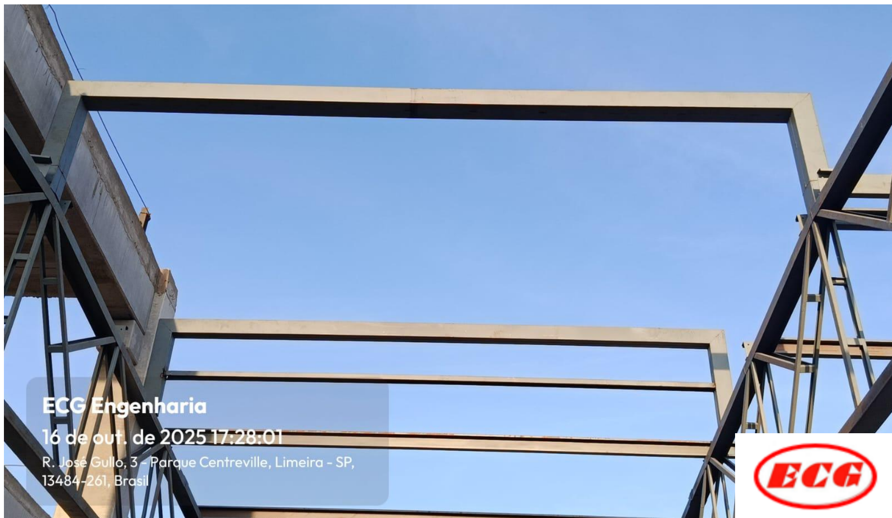
Montagem da Estrutura da Clara Boia
