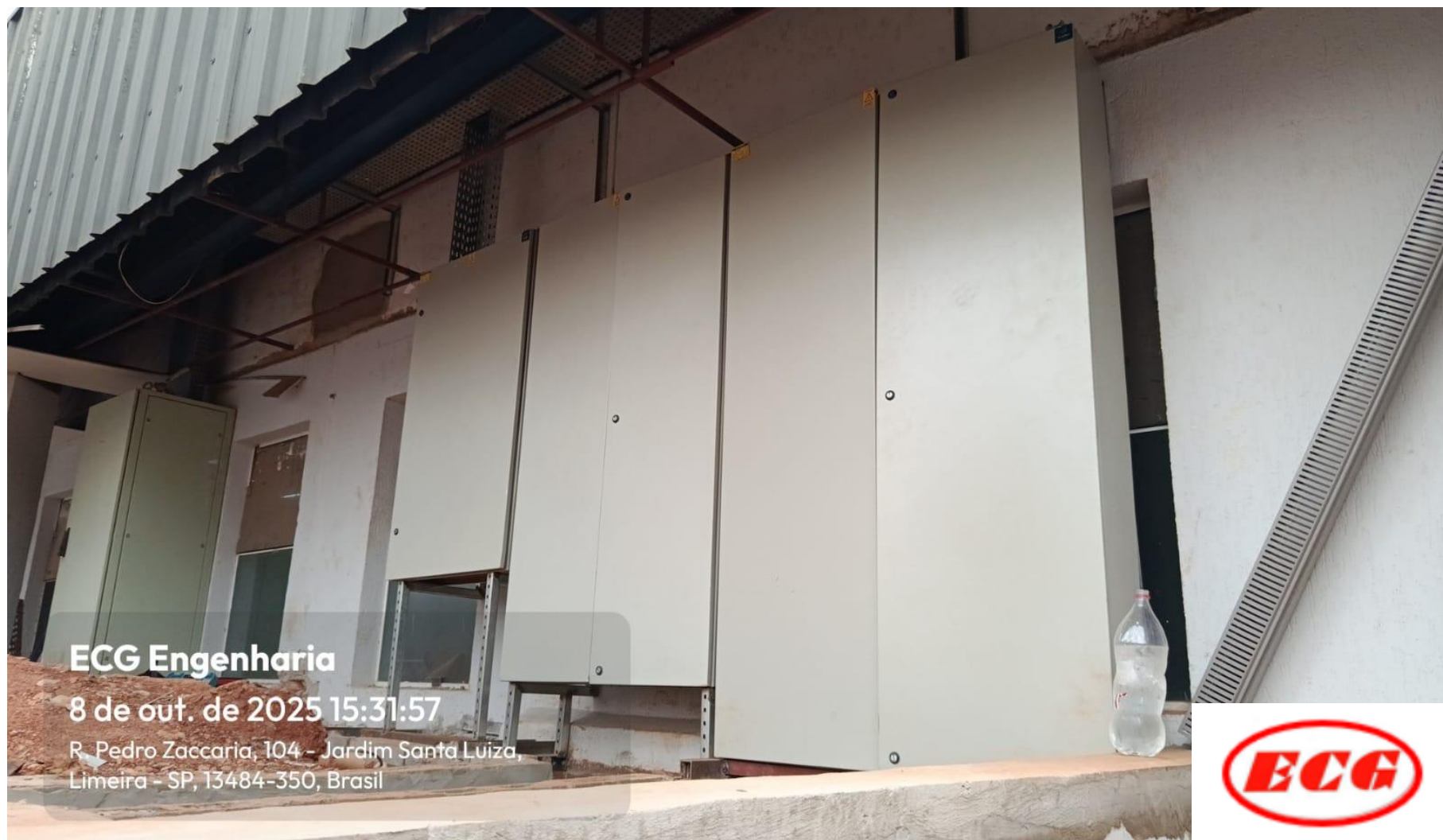
Instalação dos Quadros Elétricos
