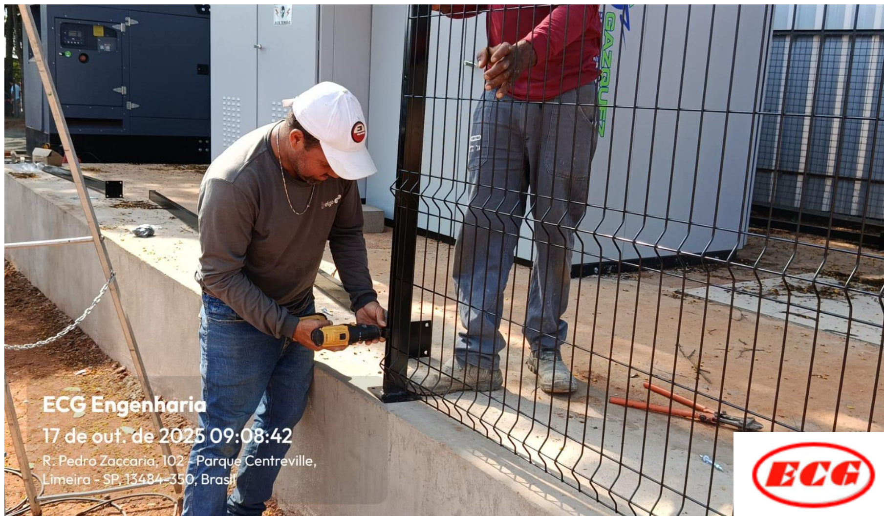
Instalação do Gradil da Cabine de Medição
