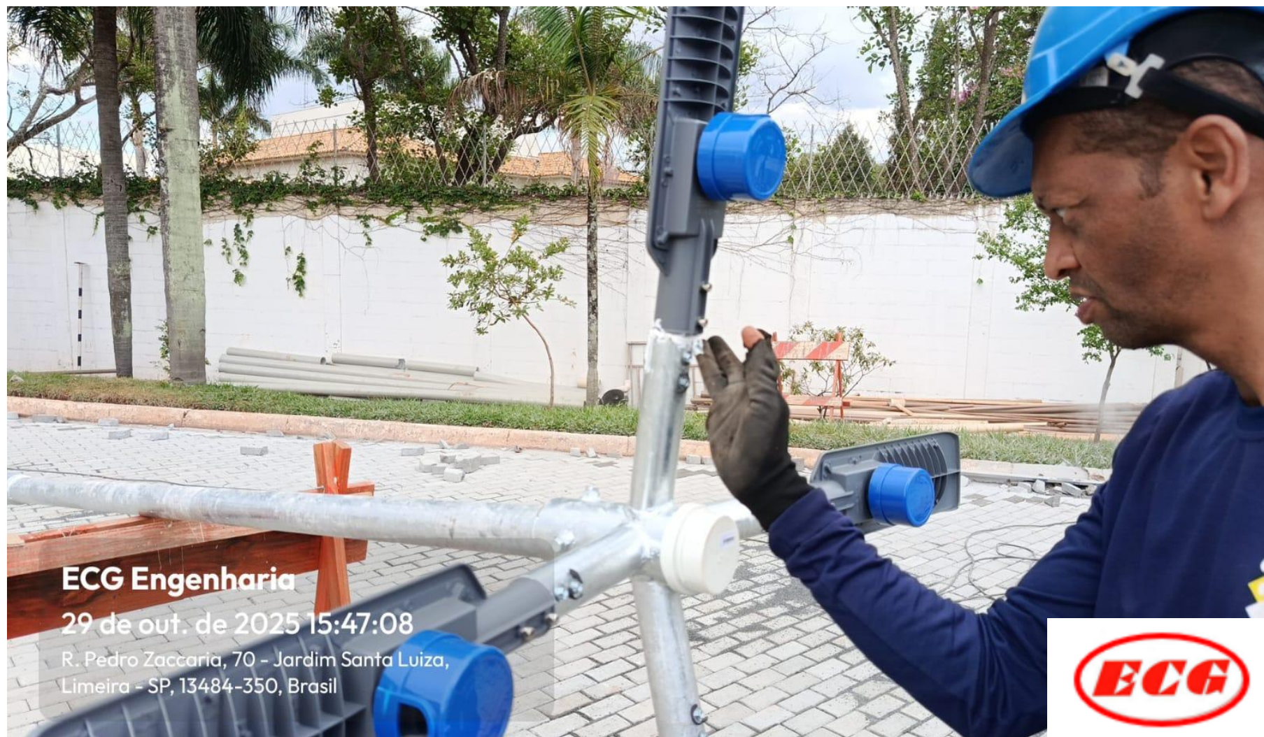
Montagem das Luminárias dos Postes do Estacionamento
