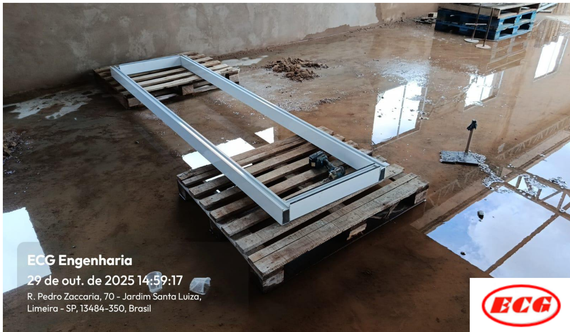
Montagem do Suporte do Vidro da Clara Boia
