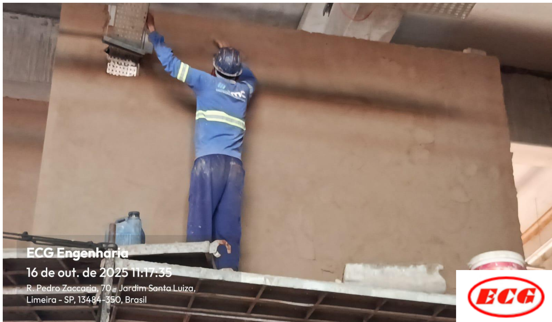
Execução do Reboco no Prédio em Ampliação
