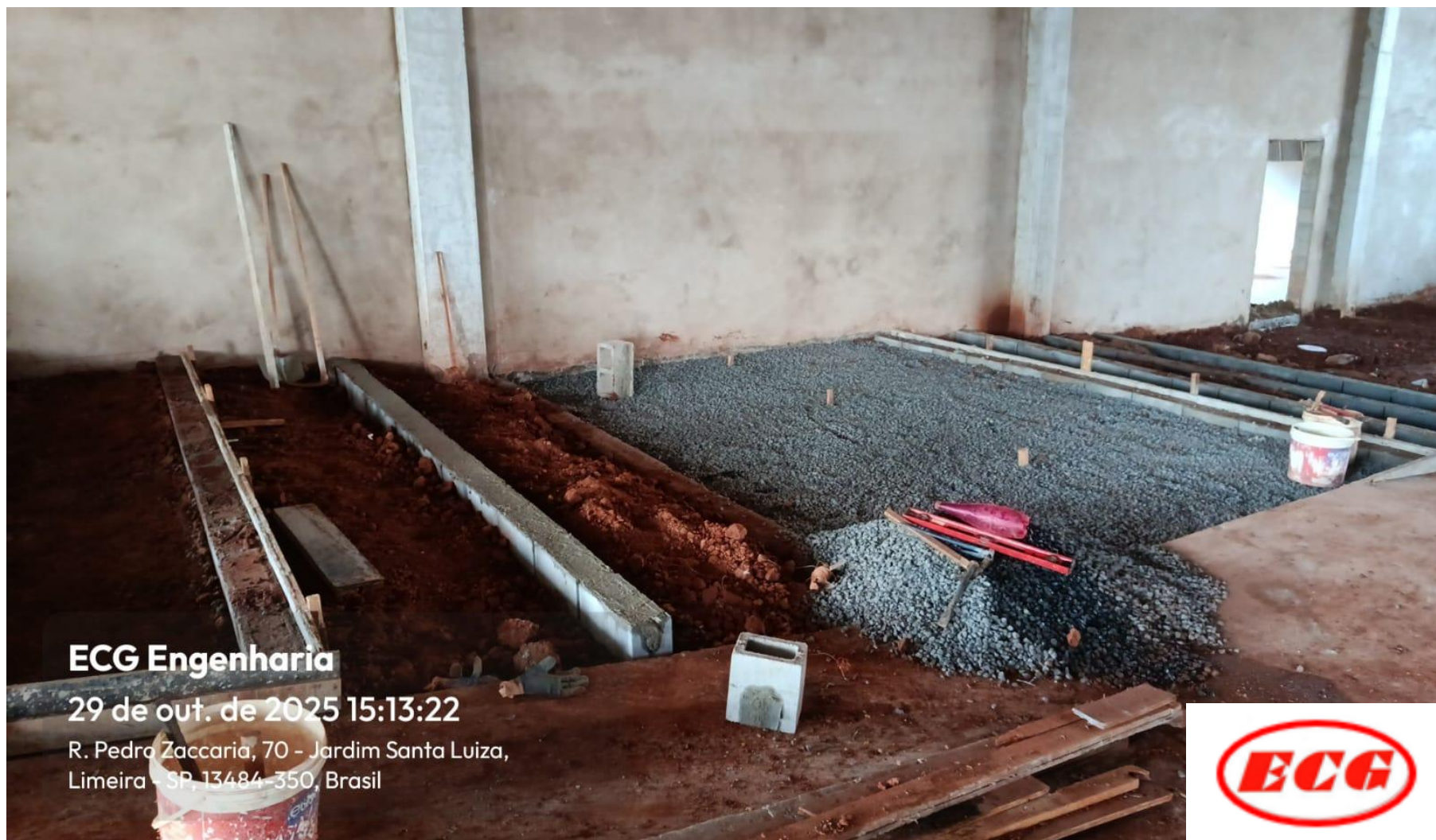
Preparação do Degrau do Plenário do Prédio em Ampliação
