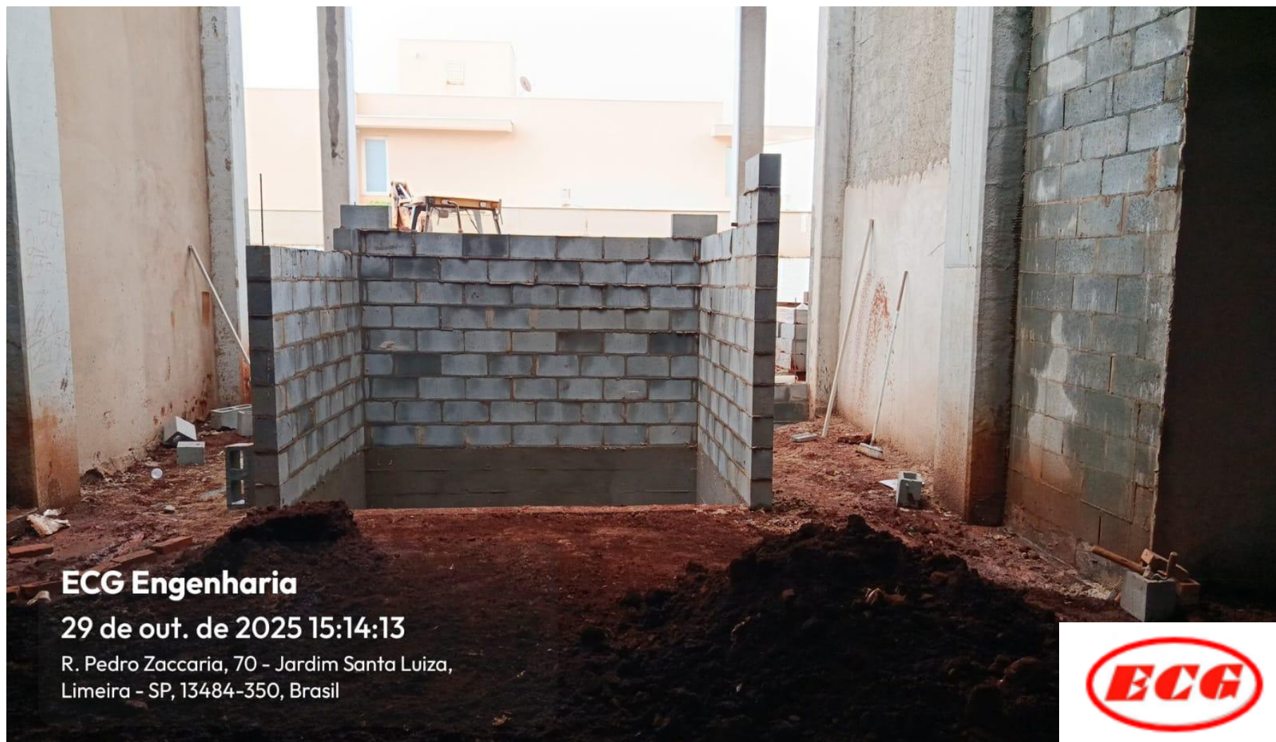
Alvenaria do Poço do Elevador sendo Executada
