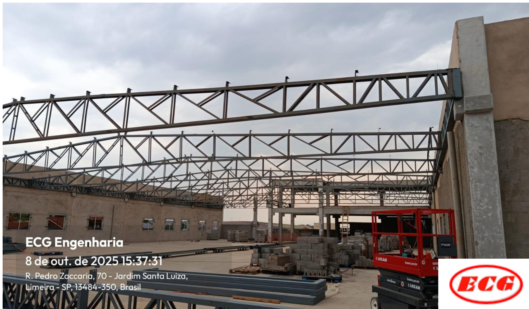
Vigas de Bordo e Tesouras Montadas
