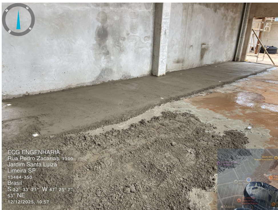
Massa de regularização – Prédio Ampliação.
