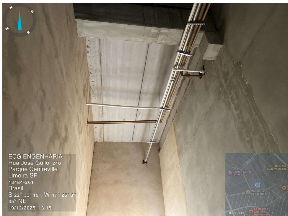
Drenos Ar-Condicionado instalados e isolados com o Elume – Prédio Ampliação.
