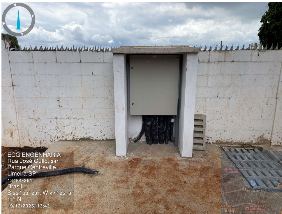
Quadros para Alimentação das Condensadoras – Sistema de Ar Condicionados – Prédio Ampliação.
