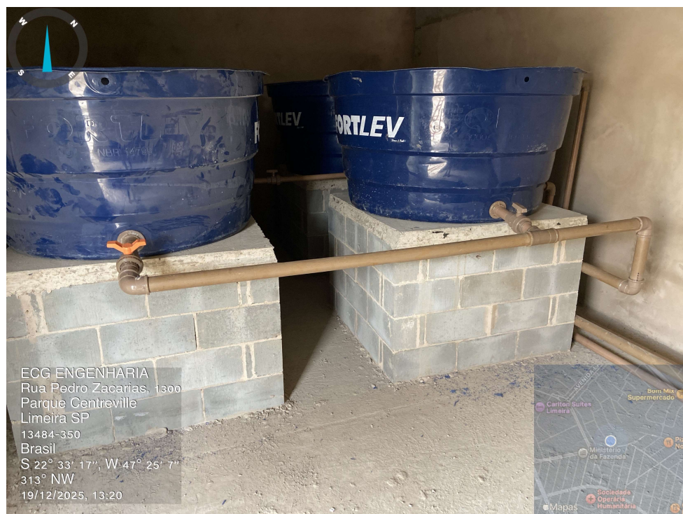
Caixas d' água instaladas - Prédio Ampliação.
