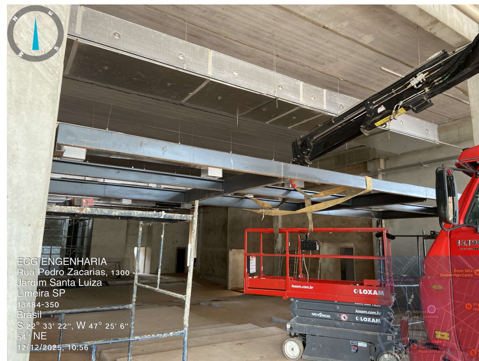
Sala suspensa no plenário, estrutura metálica iniciada – Prédio Ampliação.
