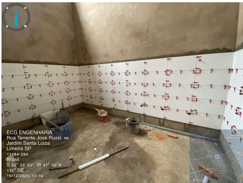
Azulejos iniciados – Prédio Ampliação.
