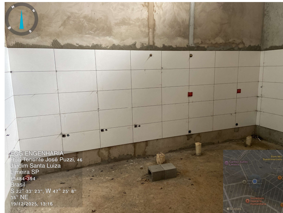
Azulejos iniciados – Prédio Ampliação.
