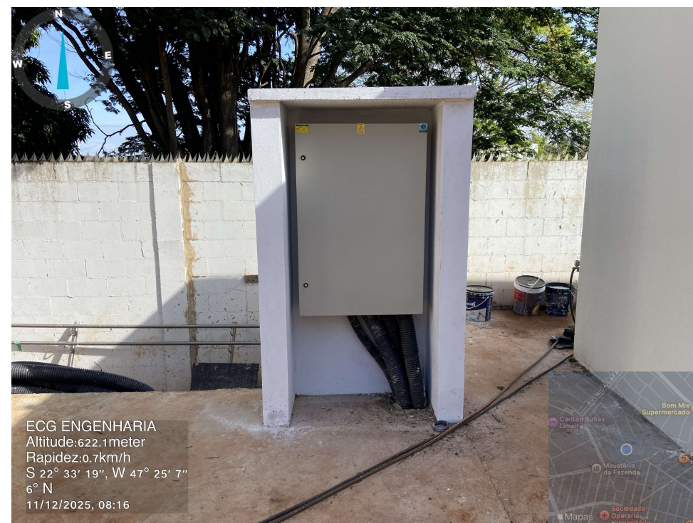
Quadros para Alimentação das Condensadoras – Sistema de Ar Condicionados – Prédio Ampliação.
