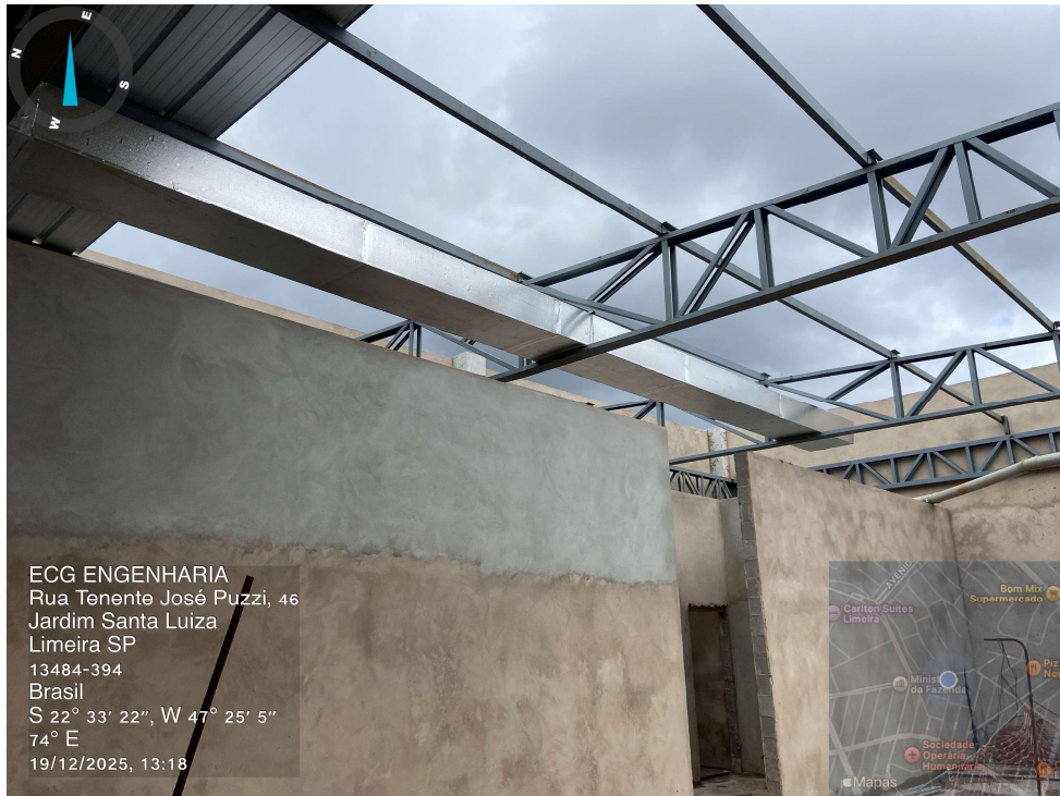
Dutos para ventilação de troca de ar – Prédio Ampliação.
