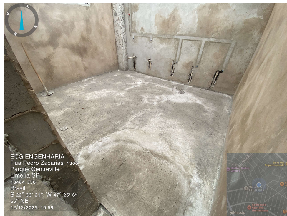
Massa de regularização – Prédio Ampliação.
