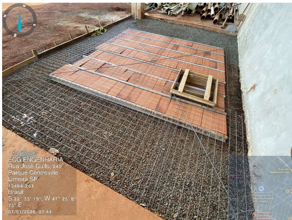
Ampliação – Preparo para concretagem da lajes da caixa enterrada.
