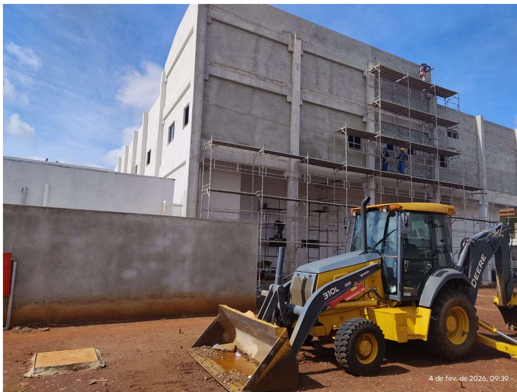
Ampliação – Fachada Fundo.
