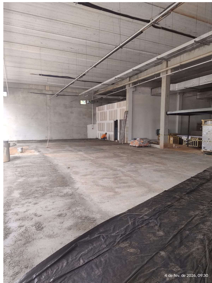
Ampliação – Hall de Entrada.
