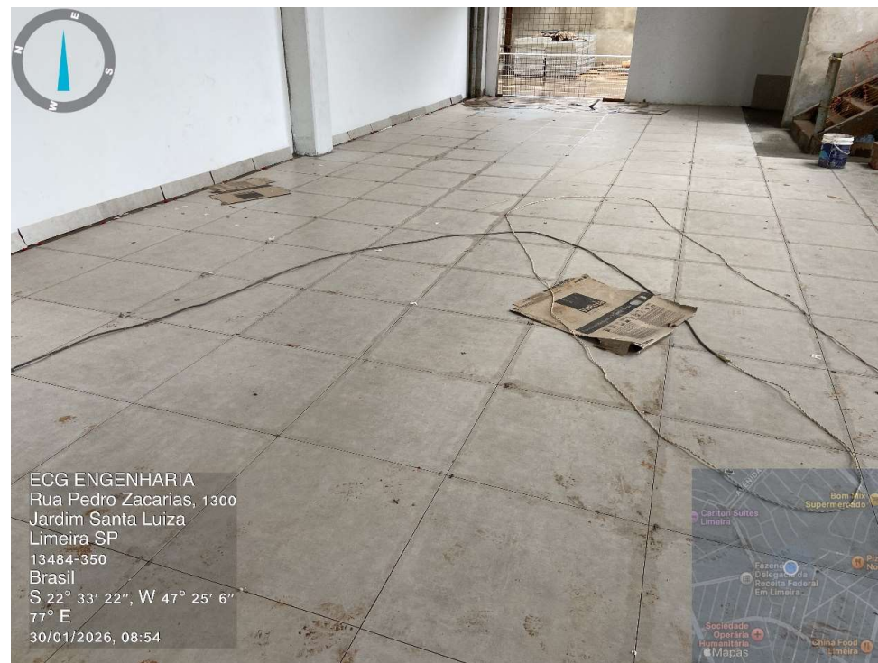
Ampliação – Instalação de porcelanato – Hall de Entrada.
