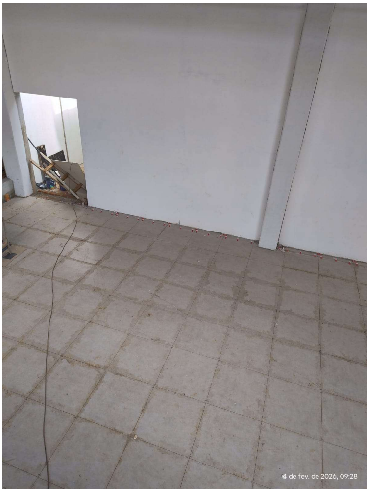
Ampliação – Hall de Entrada.
