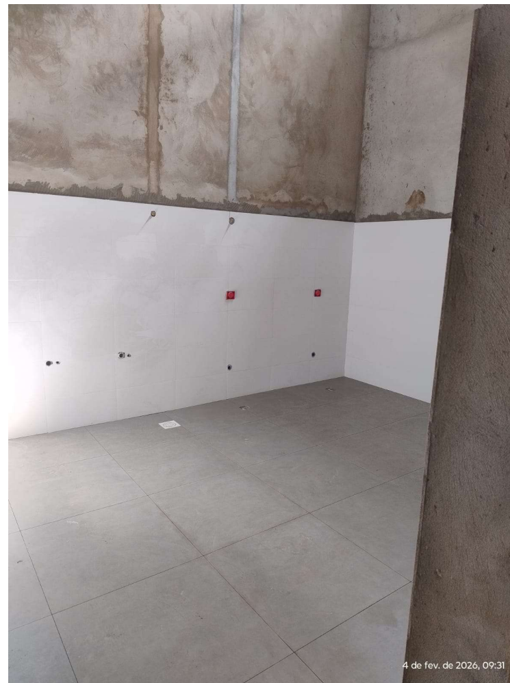
Ampliação – Banheiro Piso Superior.
