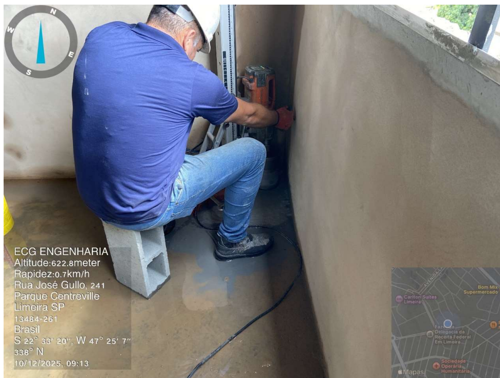
Ampliação - Furos de hidráulica e elétrica finalizados.
