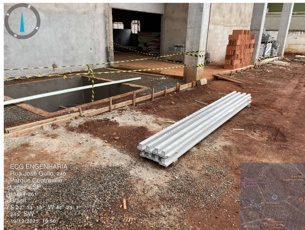
Ampliação - Laje protendida para caixa enterrada.
