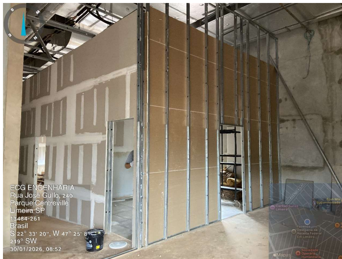
Ampliação - Paredes de drywall – Piso Térreo.
