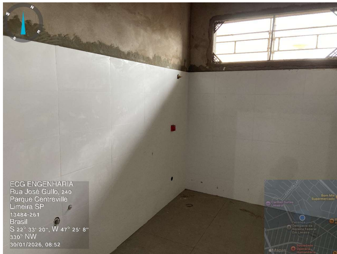
Ampliação - Azulejos e pisos em execução – Piso Térreo.
