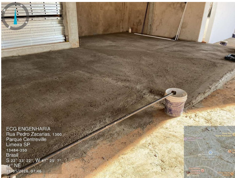
Ampliação – Contra piso – Hall de Entrada.
