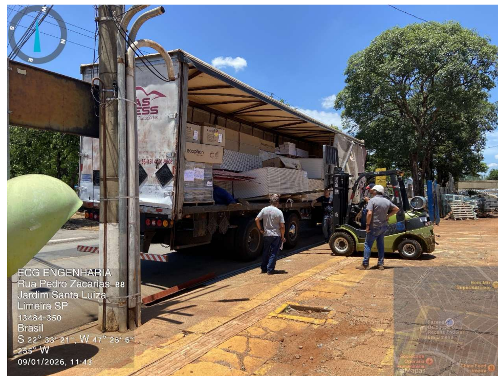
Ampliação – Chegada do material de drywall.
